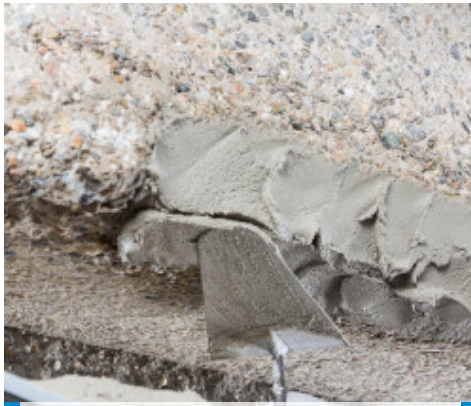
Påføring av Planitop Rasa & Ripara R4 Zero
