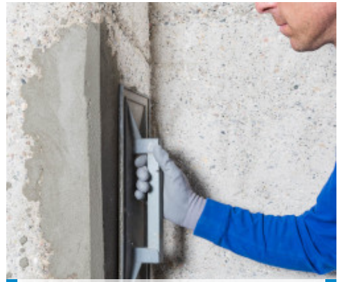
Pussing av overflaten på Planitop Rasa & Ripara R4 Zero
