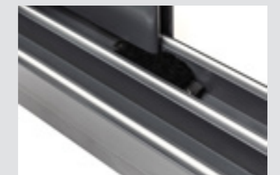
Vindtettingsbørster i skyvedørsskinne tetter ekstra mellom dørbladene
