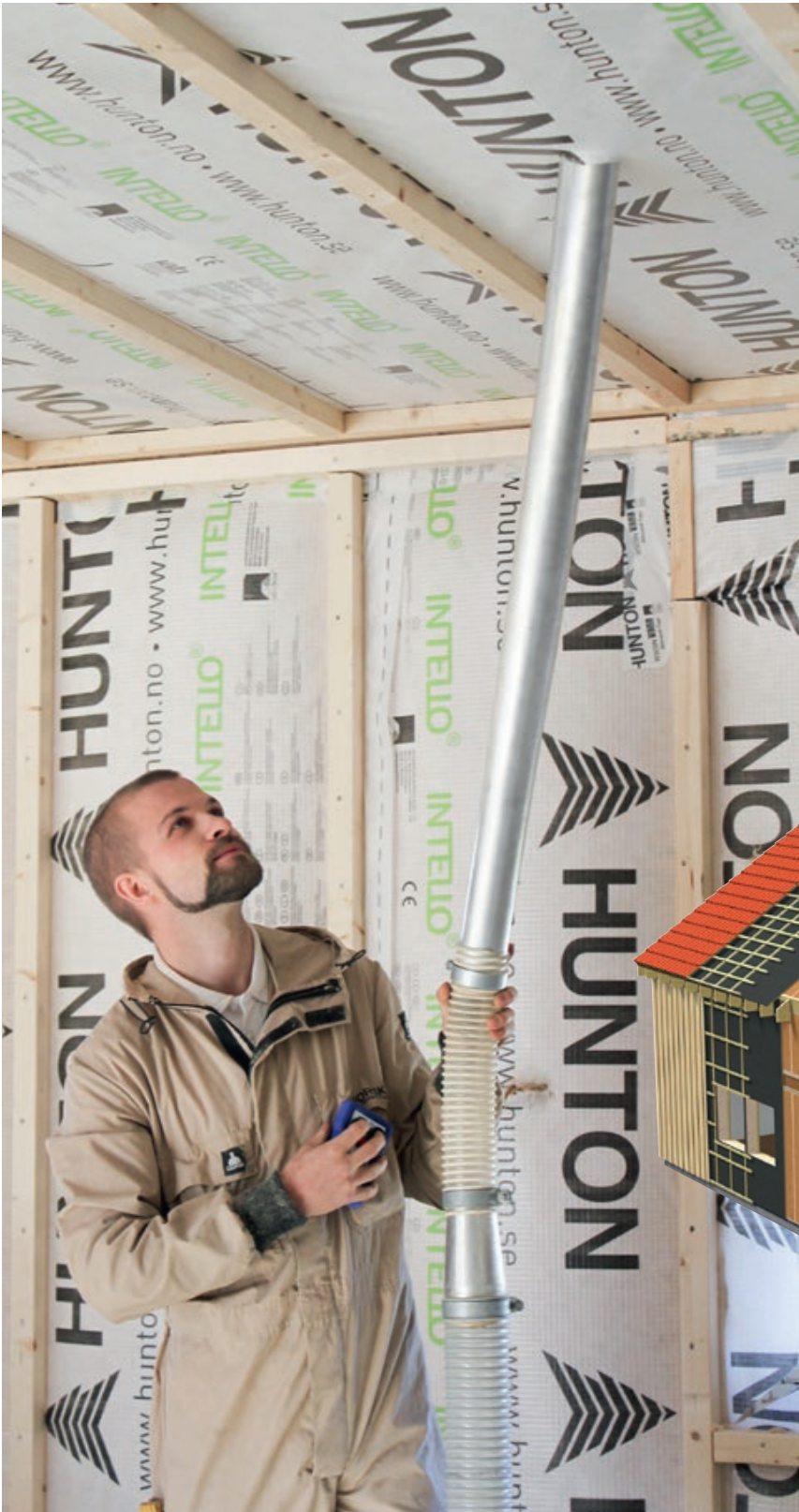
Illustrasjonen viser vegg blåseisolert med Trefiberisolasjon.
