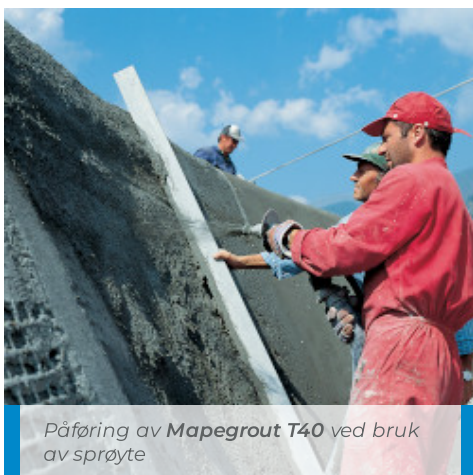
Avtrekking av overflate med brett
