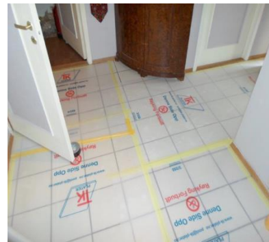
Beskyttelse av fliselagt gulv
