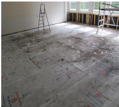
Beskyttelse av gulv ved rehabilitering
