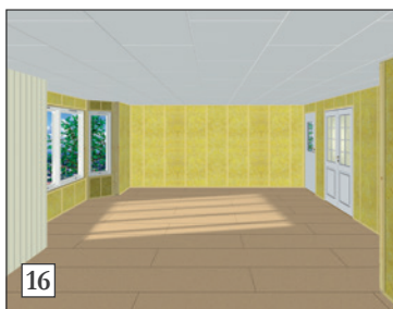
16) Resten av platene monteres på samme måten.
