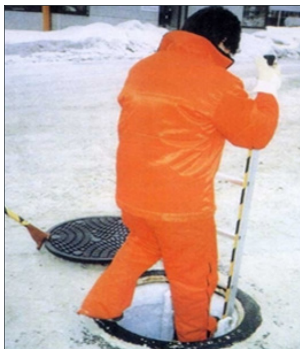
Bildet viser montert stige med sikkerhetstopp
