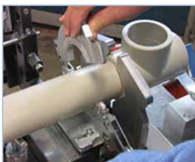
Monter røret i sveisemaskinen etter maskinens anvisninger.
