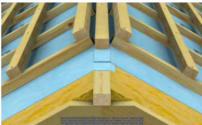
Fig. 17 Prinsipp for avslutning i mønet
