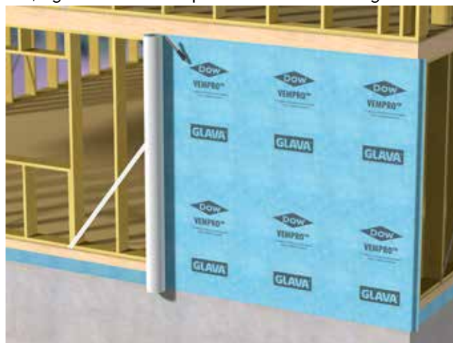
Fig. 34 Montering av etasjehøy vindsperre
