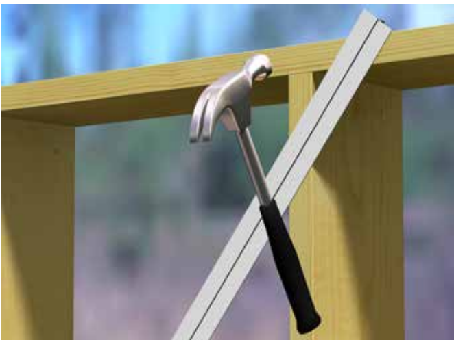
Fig. 31 Avstivningsstag bankes inn i slissen
