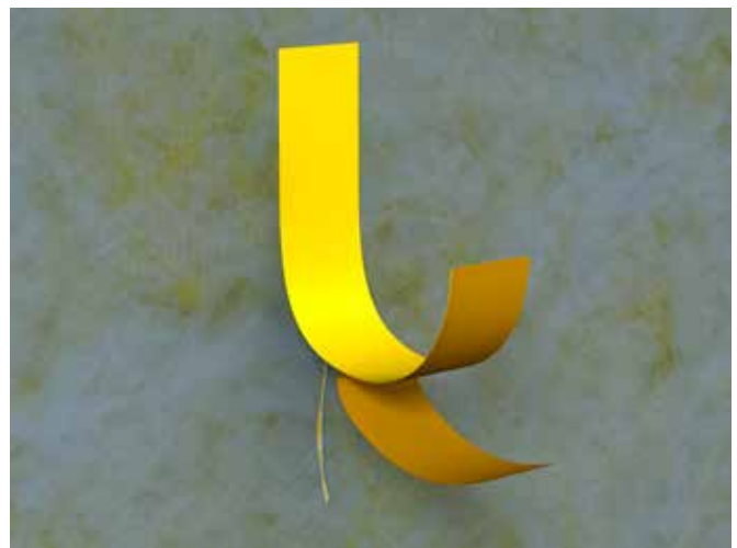
Fig. 42 Reparasjon av rift i dampsperre med dampsperretape
