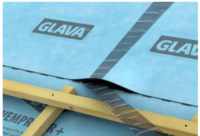
Fig. 8 Fjerning av dekkfolie på klebekanter
