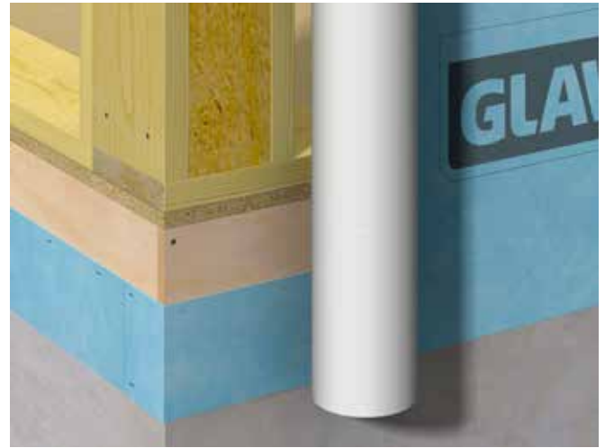
Fig. 28 Innfestet svillemembran før montering av vindsperre
