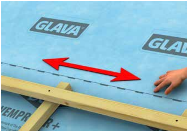
Fig. 9 Utstryking av omlegg
