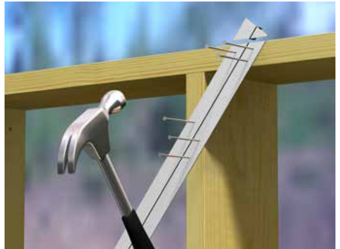
Fig. 32 Spikring av avstivningsstag
