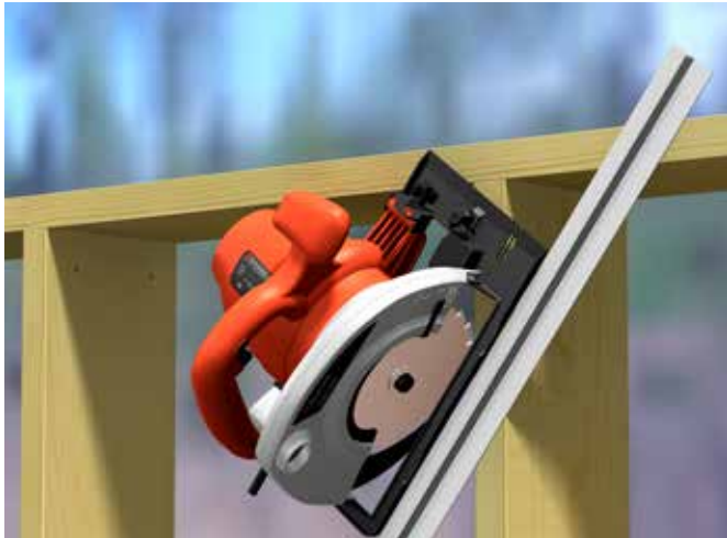
Fig. 30 Slissing i stenderverk for avstivningsstag
