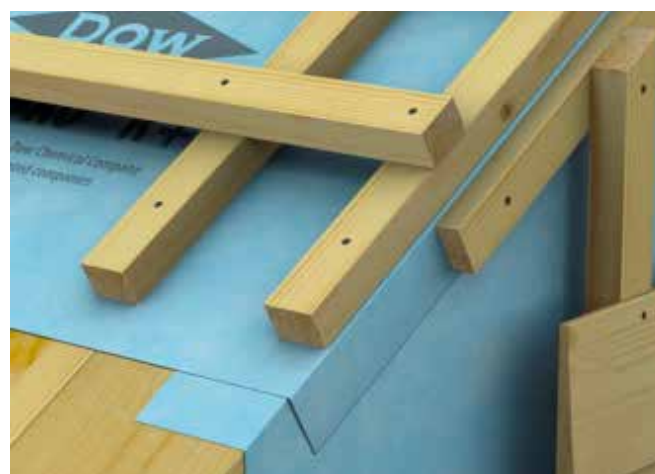
Fig. 16 Duken brettes inn og klemmes med klelekt mot vindspærren
