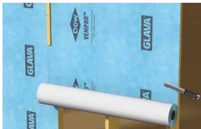
Fig. 35 Vertikal montering av vindsperre
