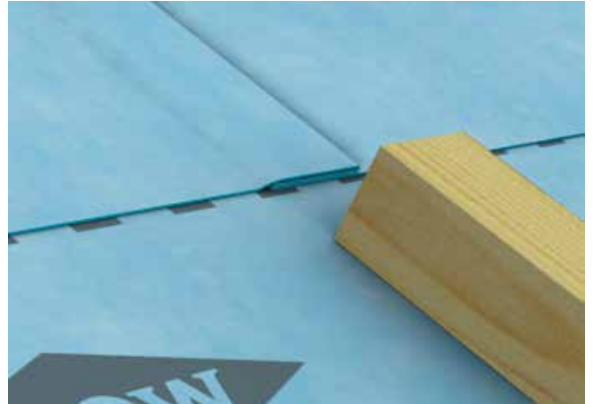
Fig. 7 Innbretting av duk ved skjøt
