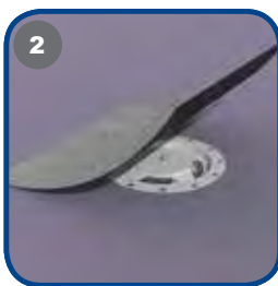
2 Sentrer slukmansjetten over sluket, og monter den.
