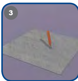
3 Skjær et første hull i mansjetten, bruk en bit av hylsen fra tette-sjiktremsen som mal (diameter 80 mm), eller bruk JAFO skjæremal.
