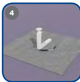
4 Skjær opp hullet, og fjern knivfoten, kniven og mansjettbiten. OBS! Bruk riktig hull i Puruskniven.
