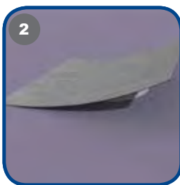
2 Sentrer slukmansjetten over sluket, og monter den. Gni mansjetten godt fast. Kontroller at det ikke blir blemmer eller folder.
