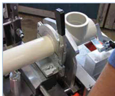
Lim sammen rør og muff.
